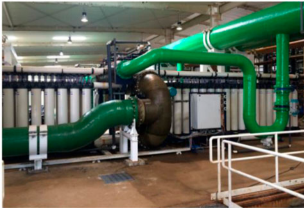
Fig. 12. Site 2—inge® T-Rack® 3.0.
