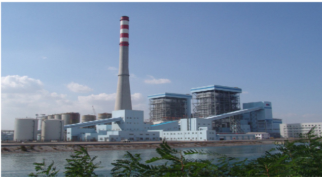
Fig. 1. Wang Tan Da Tang power plant.
