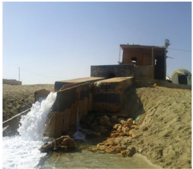
شكل ٤. نقطة تصريف الرجيع الملحي
